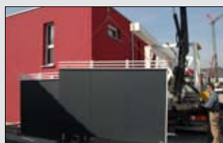
10:00 Uhr Setzen der Wände
