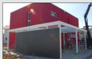
13:00 Uhr Montage der Balkenlage
