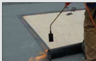
11:00 Uhr Verschweissen der Dachhaut
