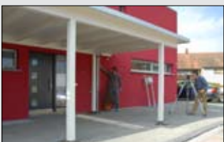
Tag 2 9:00 Uhr Nivellieren, Ausrichten
