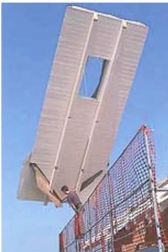
Dachelemente lassen sich auf Massiv- und Holzrahmenbauten montieren.
