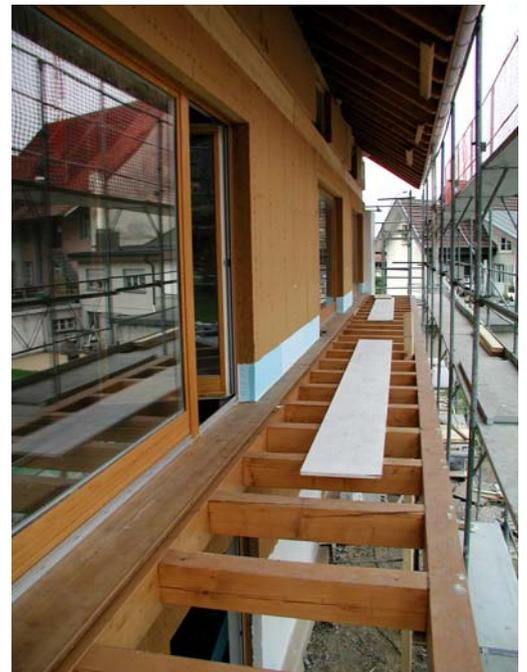
Hier wurde das Problem mit einer feuchtigkeitsunempfindlichen Styrofoam-Platte gelöst.
