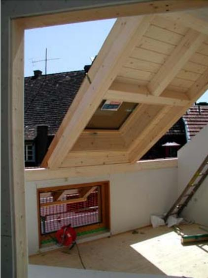
Dachelement mit sichtbarer Sparrenlage und Dachschalung mit fertig eingebautem Dachflächenfenster auf Holzrahmenbau montiert.
