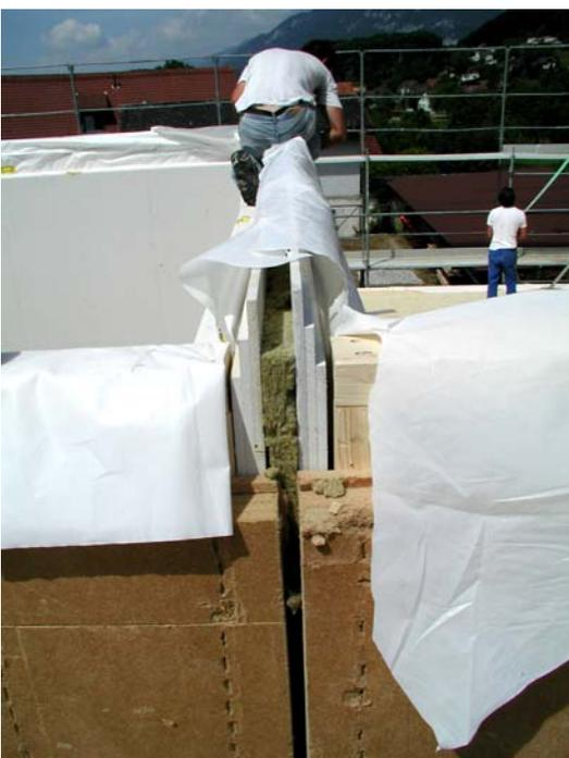
Die getrennten Schalen müssen bis unter das Unterdach laufen. Zwischen den Konterlattens muss auf dem Unterdach ein Mörtelbett eingebaut werden.
