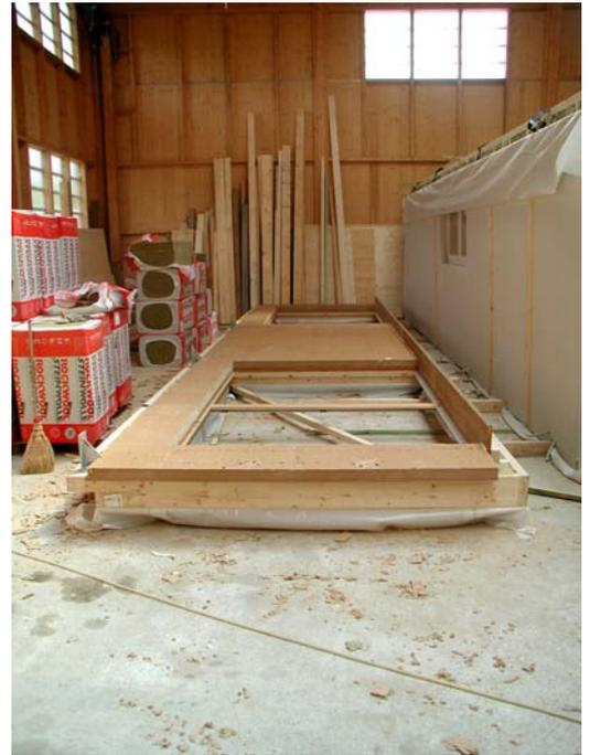
Dieses Element ist mit fertig montierten Diffutherm-Platten zu sehen. Auf die Eisenwinkel wird später der Balkon befestigt.
