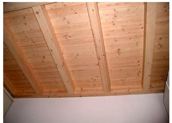
Im Massivbau eignet sich von den Holzsystemen die Balkenlage am besten
