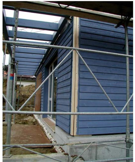
Fertig behandelte Stülp-schalungen können bereits im Werk auf die Elemente montiert werden. Eck- und horizontale Elementstöße werden am Bau fertig verkleidet.
