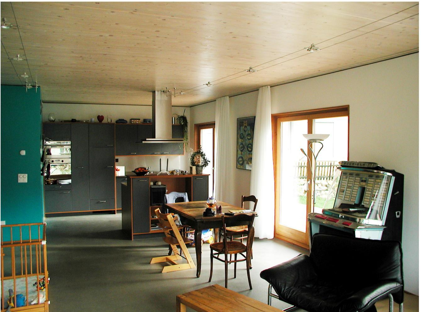
**LIGNATUR®** Kastenelemente sind industriell gefertigte Holzelemente in Zellenbauweise, die sich hervorragend für den Einsatz als tragende Decken- und Dachkonstruktionen eignen.
