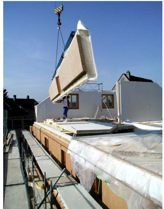
Aussenwandelemente können bis zu einer Länge von 14 m in einem Stück gebaut werden.
