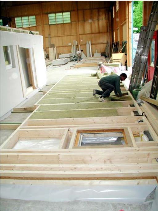
Hier werden die Felder zwischen den Ständern ausisoliert. Fermacellplatten, Dampfbremse und Fenster sind bereits montiert.
