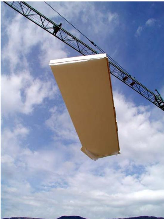
Mit 3-Schicht Naturholzplatten können schlank und filigran wirkende Vordachkonstruktionen erstellt werden.
