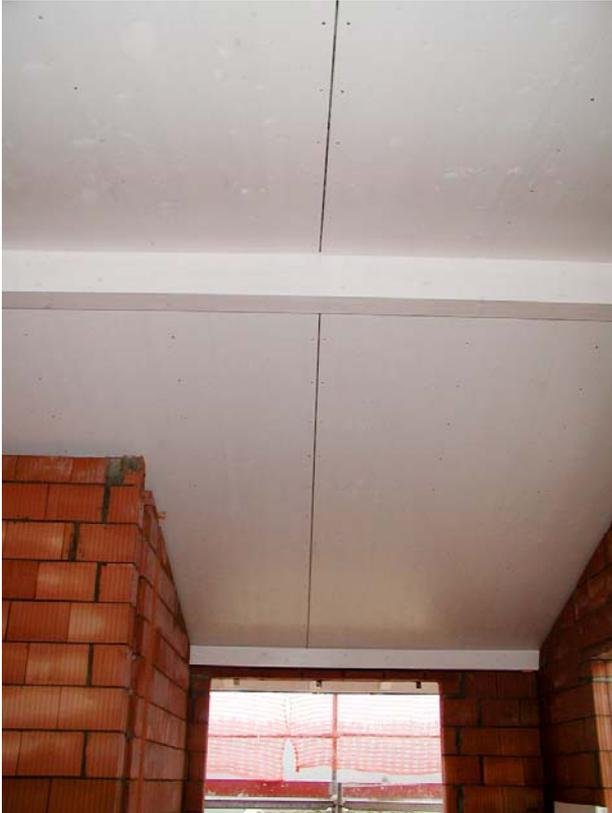
Dachverkleidungen mit 3-Schichtplatten sind eine echte Alternative zu den gebräuchlichen Verkleidungsformen wie Täfer oder Sichtsparren mit Dachschalung.
