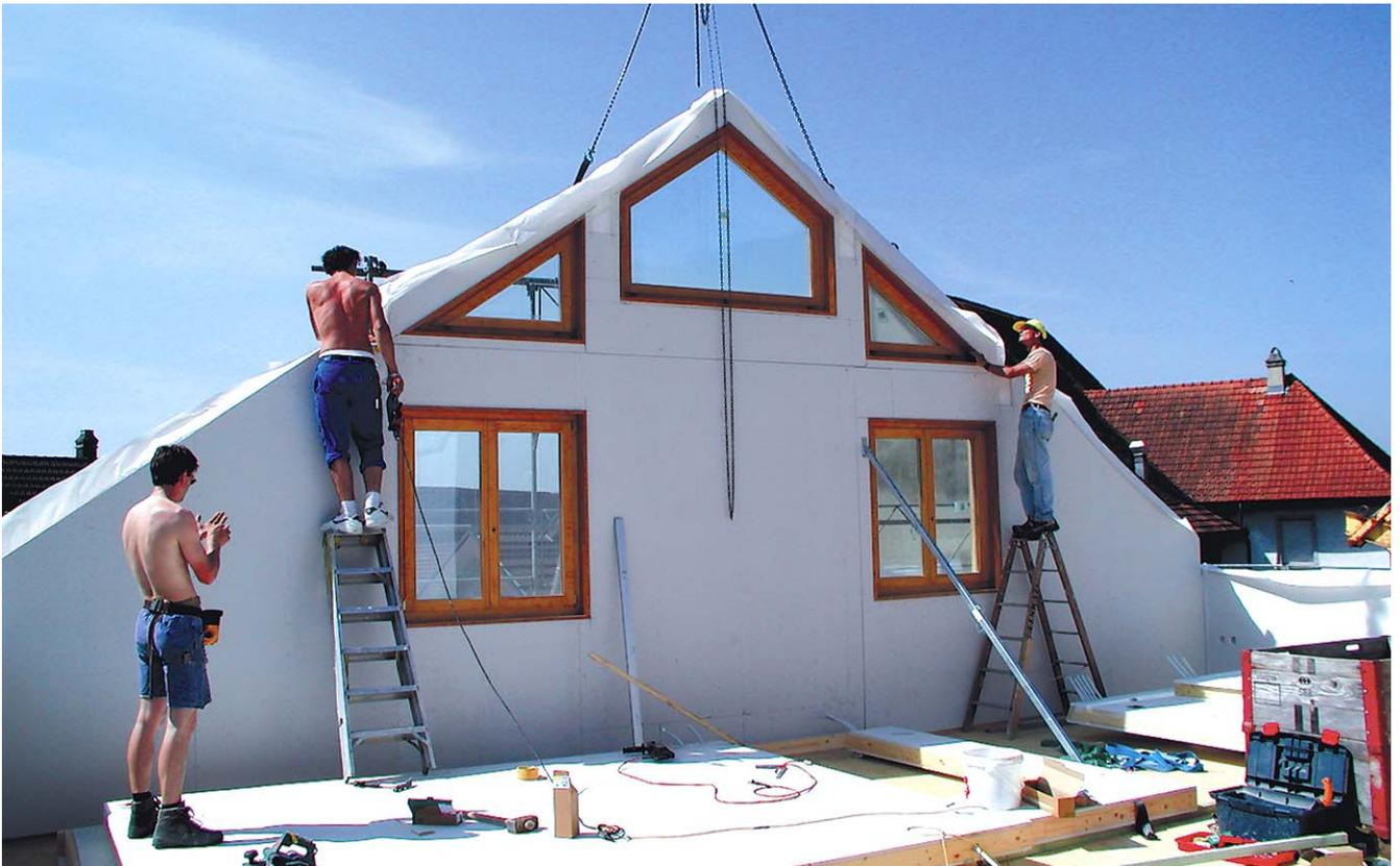
Die Fenster werden, wie bei dieser Giebelwand, bereits im Werk fertig in die Elemente eingebaut. Bei diesem Haus wurden die Fensterleibungen mit Kirschenholz ausgeführt.
