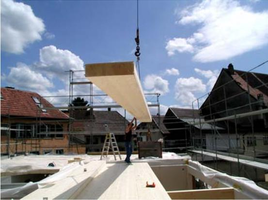
**BSH Deckenelemente** sind Brettschichtholzträger in der Breite von ca. 60 cm. Sie werden in einer Industrie- und einer Sichtqualität in Längen bis zu 13 m<sup>1</sup> angeboten.
