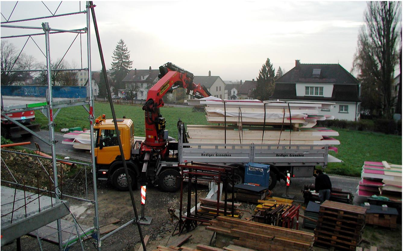
Dachelemente sind in der Regel nicht schwerer als 800 kg und können somit problemlos mit dem Baustellenkran montiert werden.
