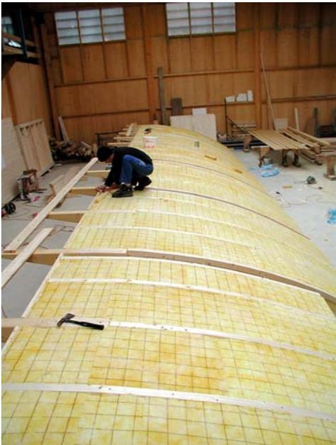
Auch Dachformen wie dieses Tonnendach können vorgefertigt und innert kurzer Zeit auf der Baustelle montiert werden.
