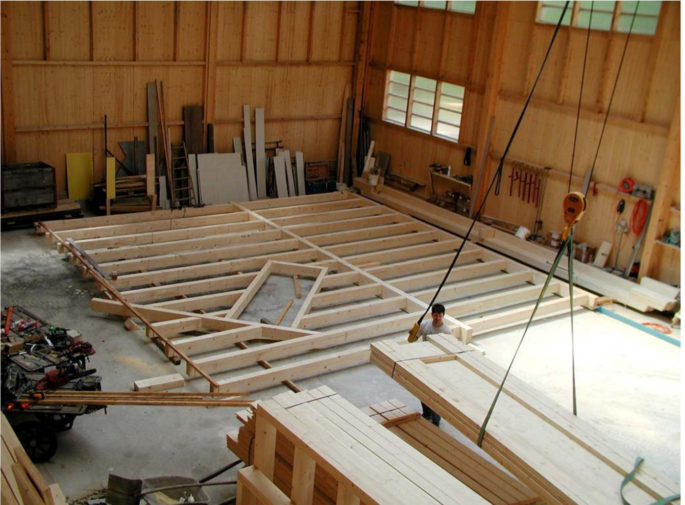
Im Werk zusammengestellte Balkenlage mit Treppenauswechslung vor der Montage der Bodenschalung. Zu diesem Zeitpunkt sind die Balken und die Bodenschalung bereits fertig behandelt. Nach der Montage der Bodenschalung kann die Balkenlage zu transportierbaren Elementen zerlegt und auf dem Bau auf die entsprechenden Auflager montiert werden.
