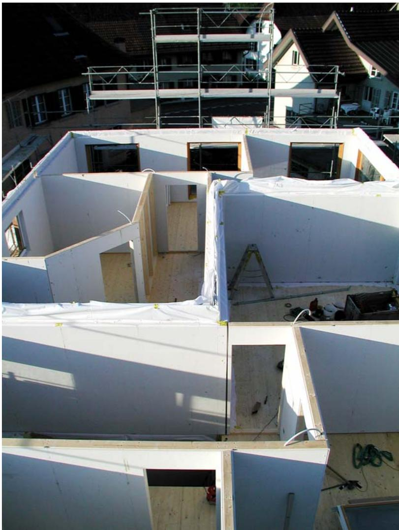
Mit Fermacell beplankte Wände eignen sich hervorragend für glatte Oberflächen und sind strapazierfähiger als Weissputze.
