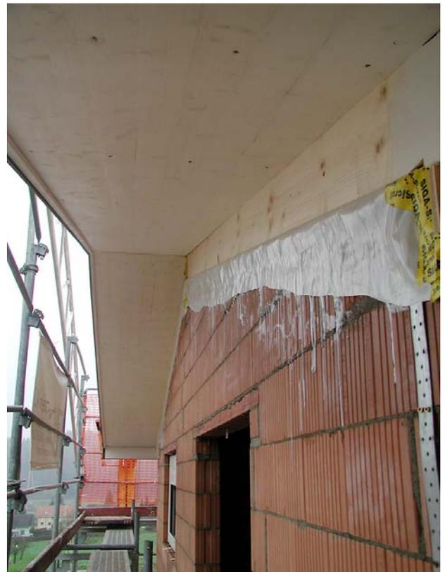
Bei diesem Dach wurden die Schwellen und die Firstpfette auf der Giebelmauer geschnitten und die Vordachplatte ist von unten, auf der Ebene der Konterlatten, an seitlich auskragende Hölzer befestigt worden.
