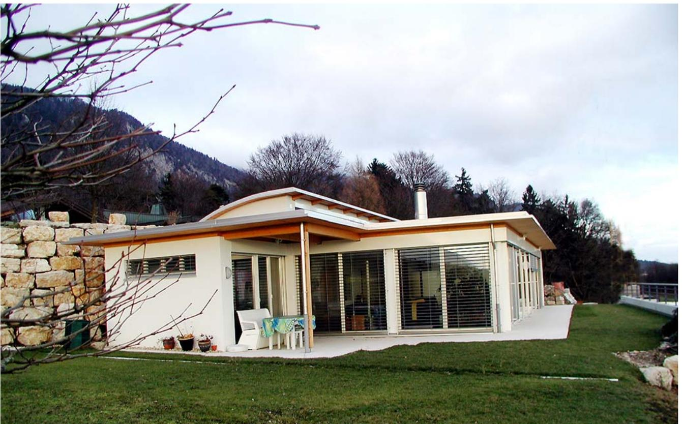
Flachdach mit Vordach aus 3-Schichtplatten, 42mm
