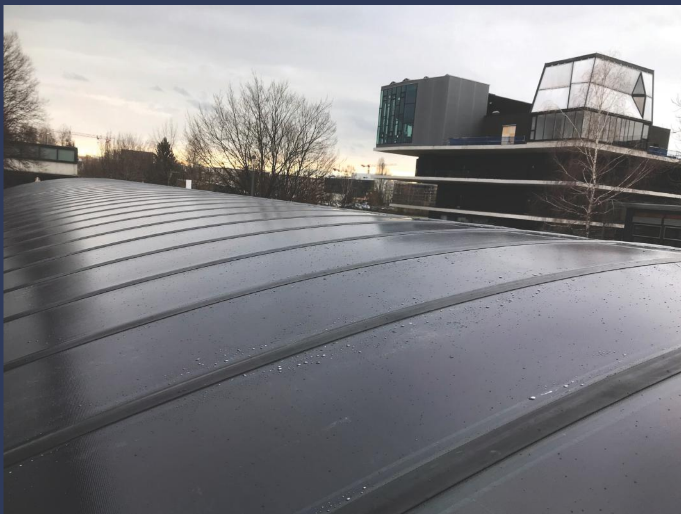
Bilder Titel- und Rückseite: Solarcarport Sunshell bei Empa Dübendorf Planung & Realisierung: swisscarport.ch®
