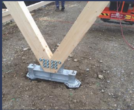
Schraubfundamente mit Stahltraverse
