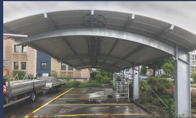
Tragkonstruktion Sunshell
