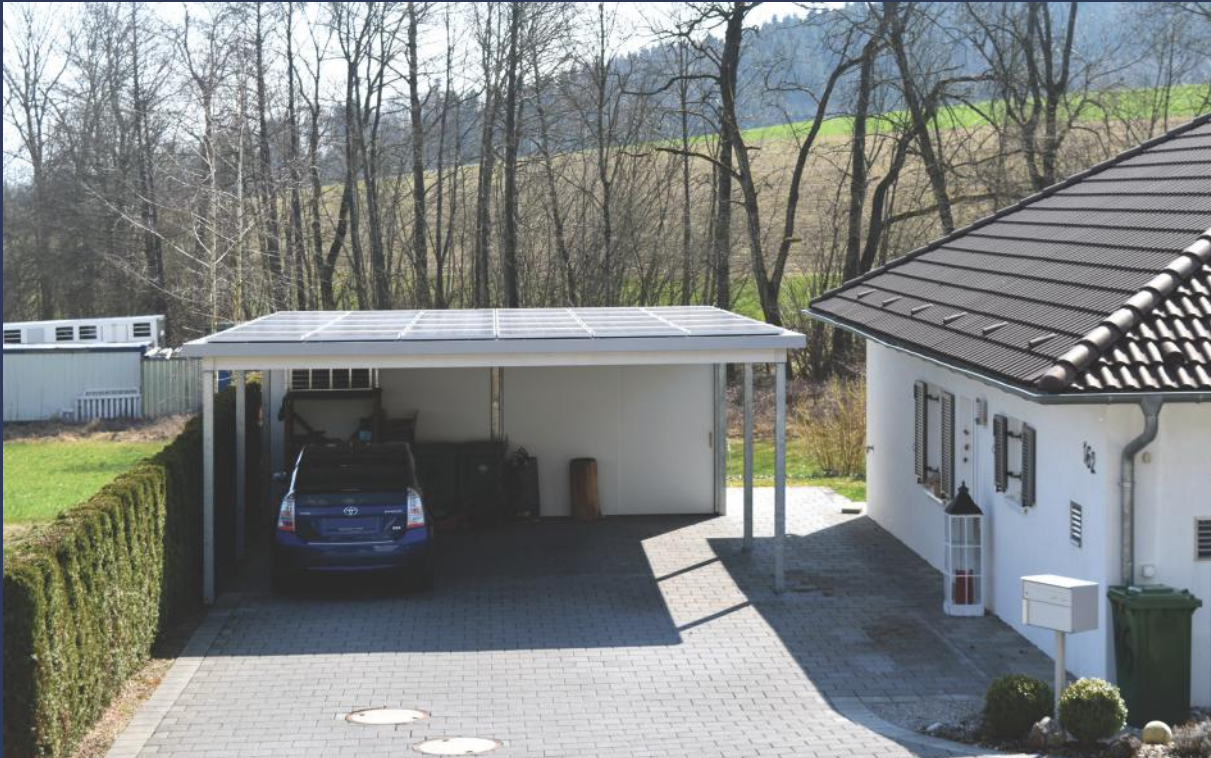
Smartport mit Photovoltaik-Anlage | Planung & Realisierung: swisscarport.ch®
