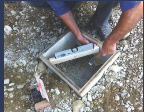
Punktfundament in Beton
