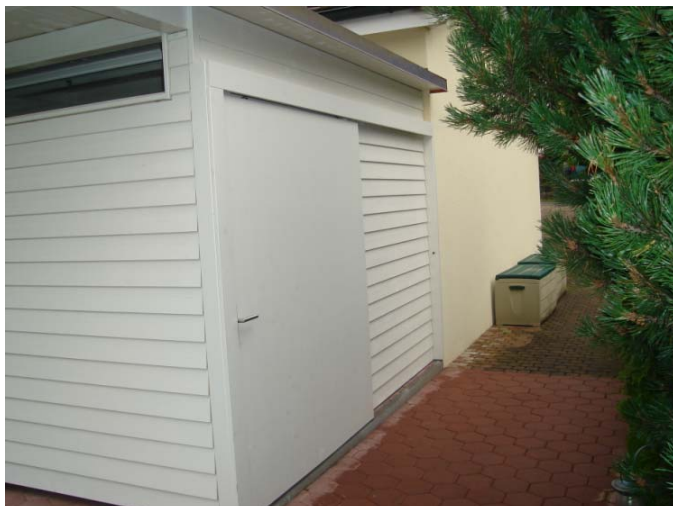
Schiebetür Aussen auf Wand montiert.
