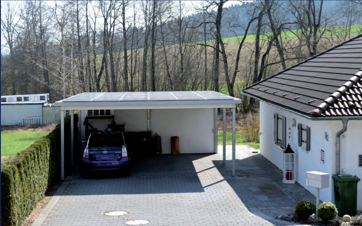
Smartport mit Photovoltaik-Anlage | Planung & Realisierung: swisscarport.ch®
