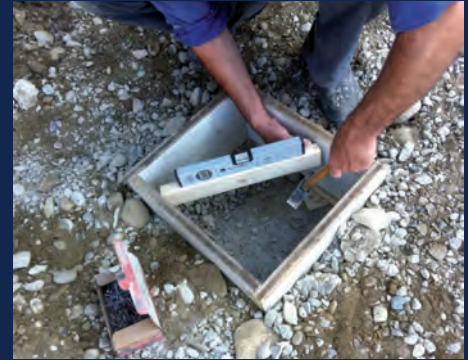
Punktfundament in Beton
