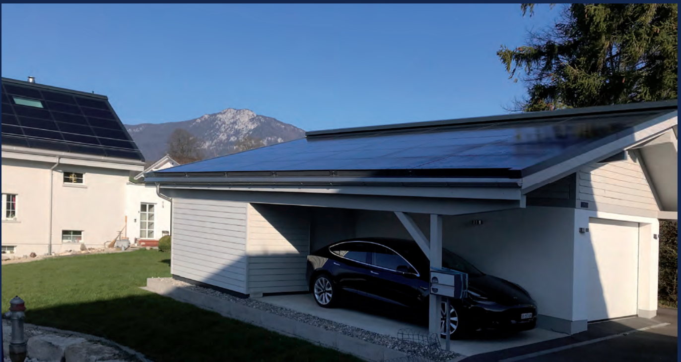
Indachanlage auf Garage und Wohnhaus | Planung & Realisierung: swisscarport.ch®
