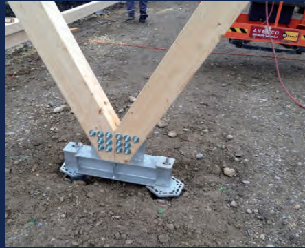
Schraubfundamente mit Stahltraverse
