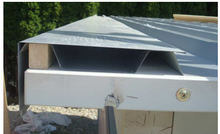
Erste Blechwelle über Unterlageleiste
