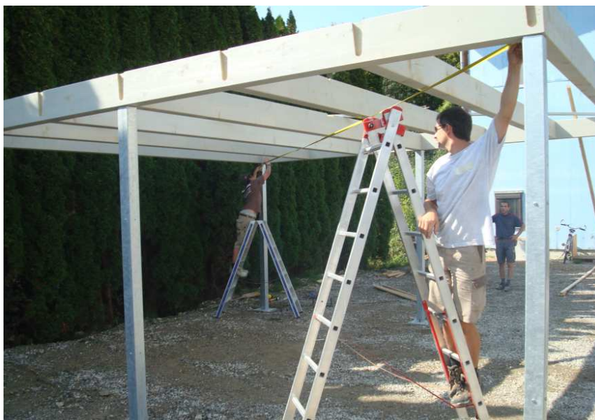
Winkelkontrolle mit dem Messband
