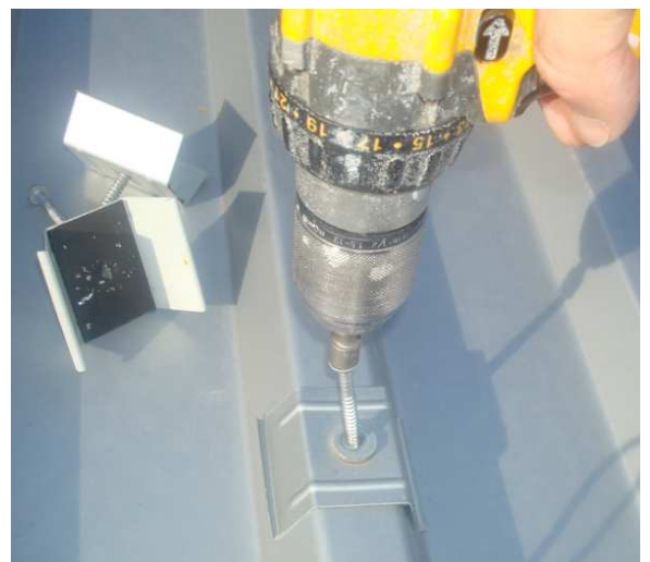
Schrauber mit 8 mm sechskant Aufnahme
