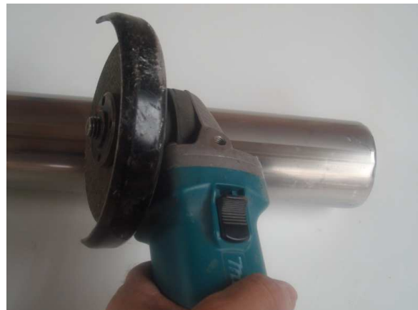
Rohr mit Trennscheibe zuschneiden
