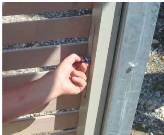
Befestigung der Wand an Metallpfosten
