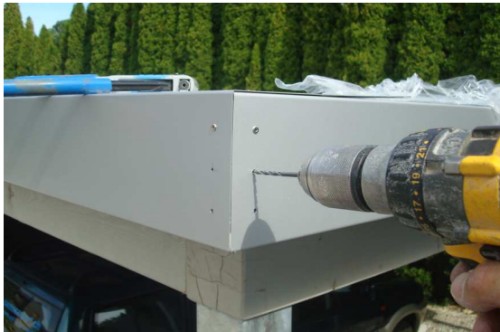
Durch Blenden Eckblech bohren
