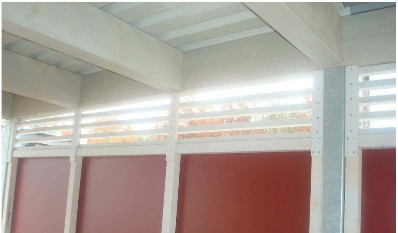
Lattenlichtband von innen gesehen
