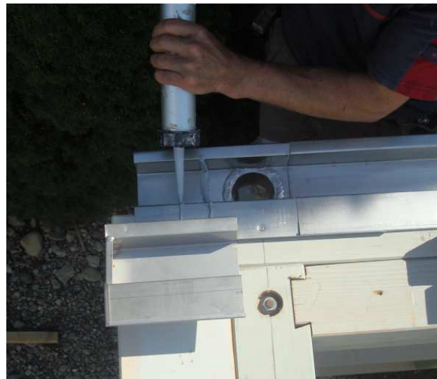
Rinnenboden mit Stutzenstück verkleben
