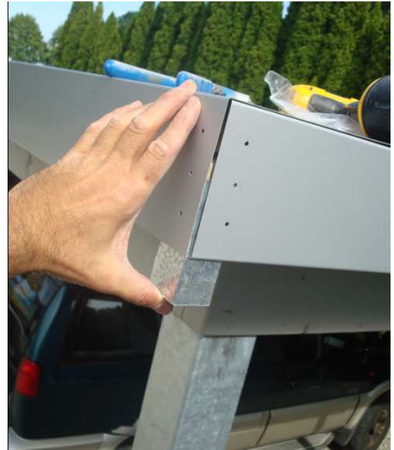
Eckbleche unter Blenden schieben
