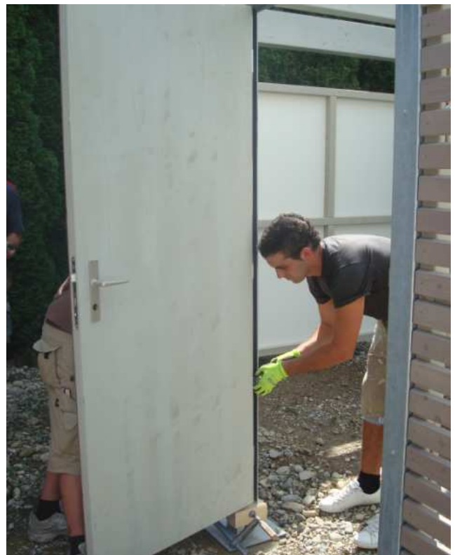
Befestigung Tür an Pfosten
