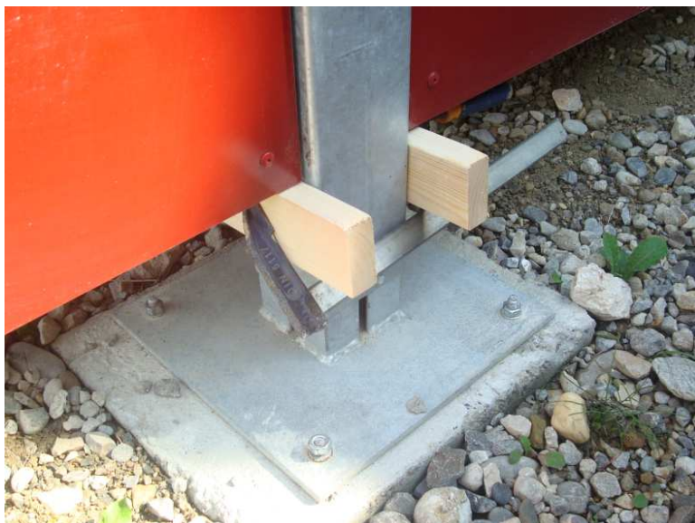
Auflagehölzer seitlich an Pfosten montiert
