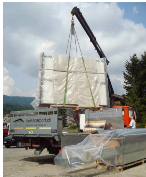
Anlieferung mit LKW mit Ladekran
