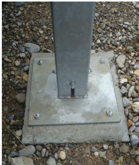
Fertiges Fundament mit aufgeschraubtem Pfosten
