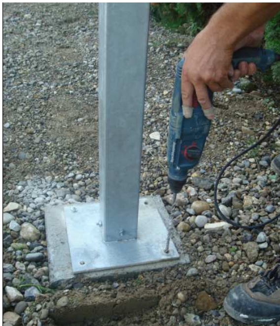
Bohrung für Betonankerschrauben
