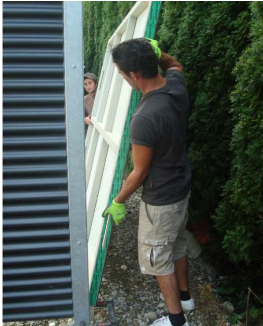
Wand zwischen Pfosten stellen
