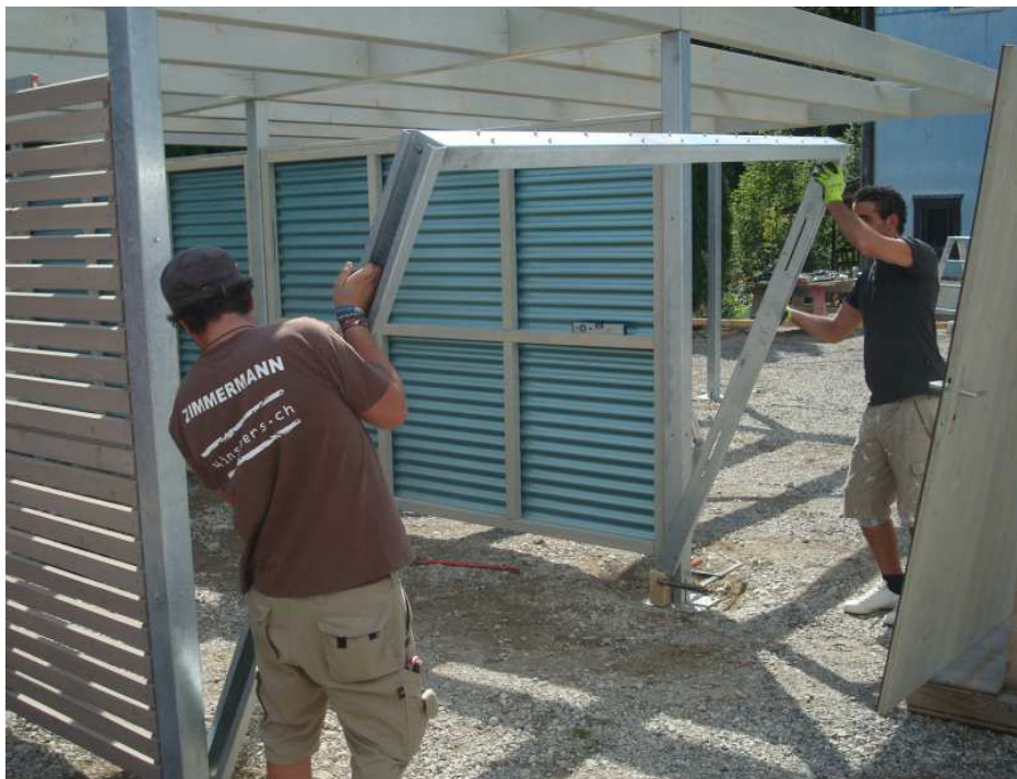
Schiebetürrahmen zwischen Pfosten einschieben
