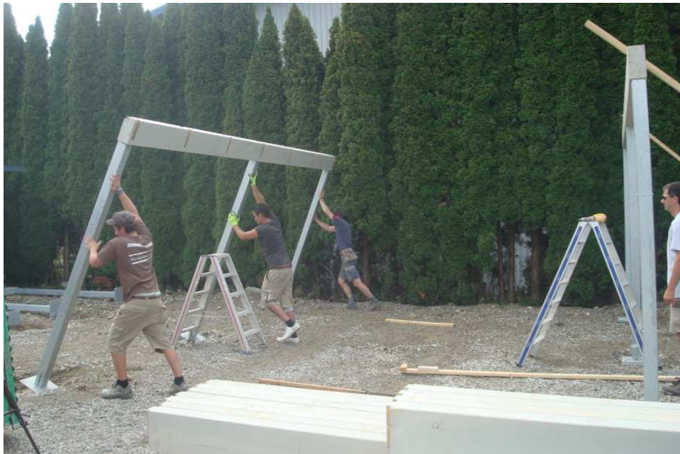
Aufstellen des zweiten Hauptträgers
