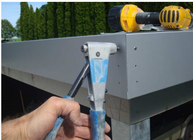
Durch Blenden Eckblech bohren
