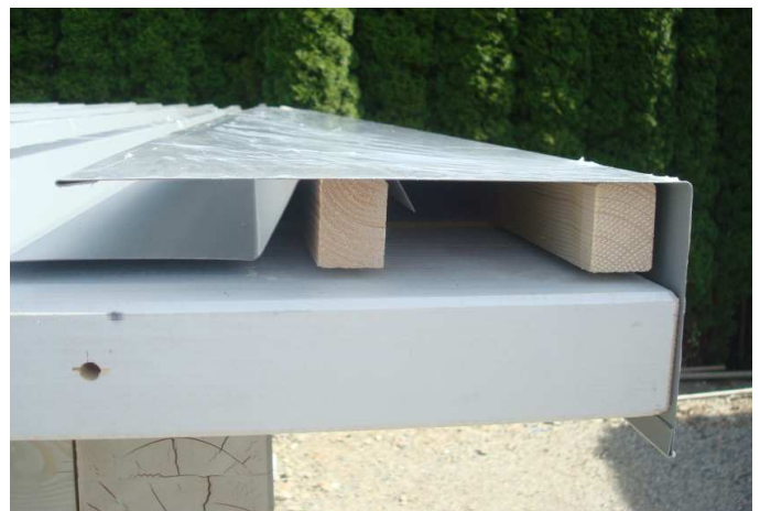
Unterlageleisten als Auflage der Blende
