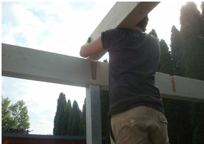
Hauptträger mit Schwalbenschwanzverbindung
