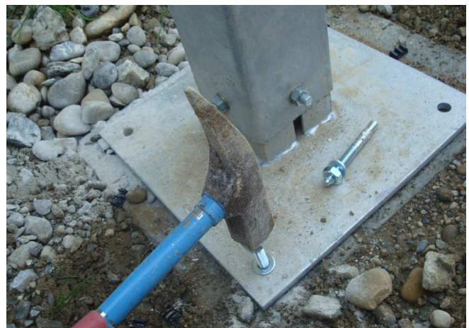
Setzen des Betonankers
