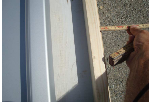
Unterlageleiste 1 cm von Ausserkante
