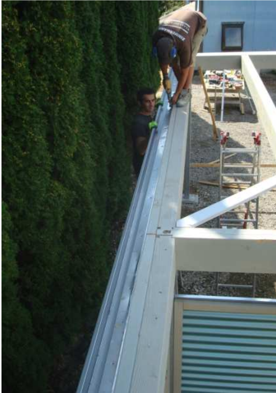
Traubalken mit bereits montierter Regenrinne
