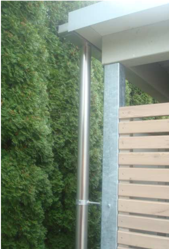
Fertig montierte Regenrinne mit Ablaufrohr
