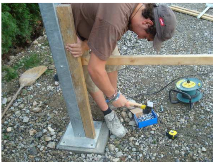
Richten des Pfostens immer mit Schlagunterlage aus Holz
