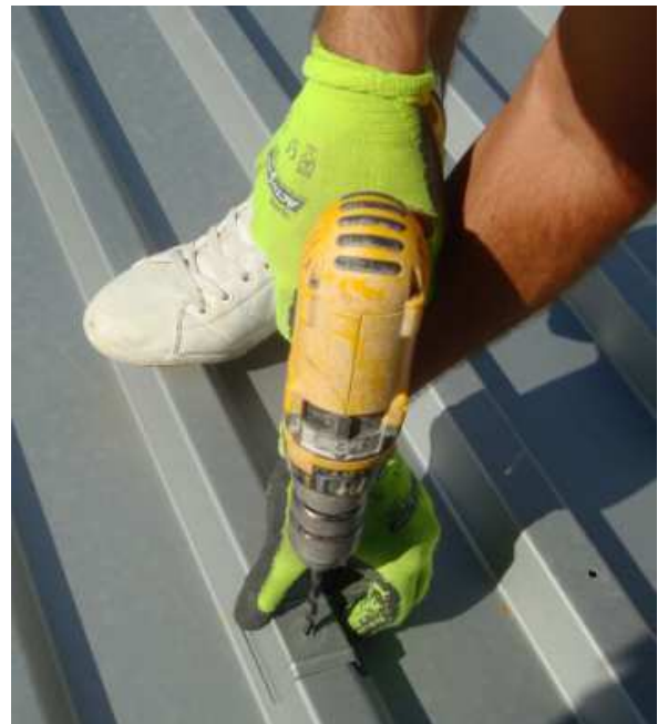
Bohrmaschine mit 8 mm Bohrer
