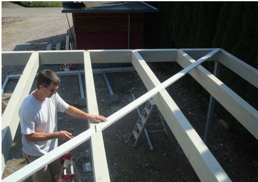
Windverband in Aussparungen montieren
