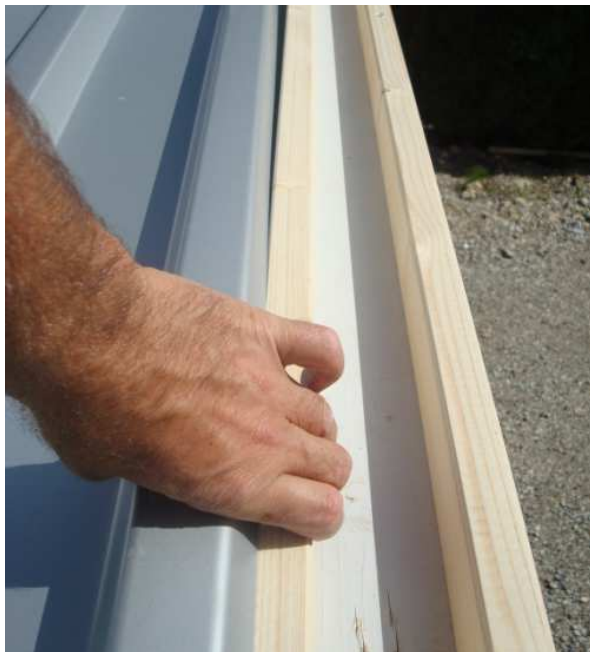
Zweite Unterlageleiste unter letzte Welle
