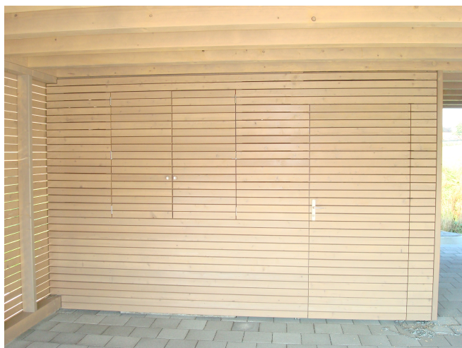
Türblatt & Elektrokasten Flächenbündig beplankt mit Lärchenlamellenschalung
