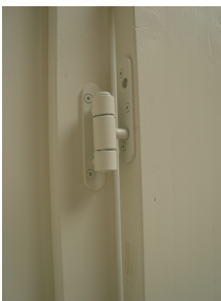
3 Stück Anuba-Bänder mit Verstärkungsplatten halten die Tür
